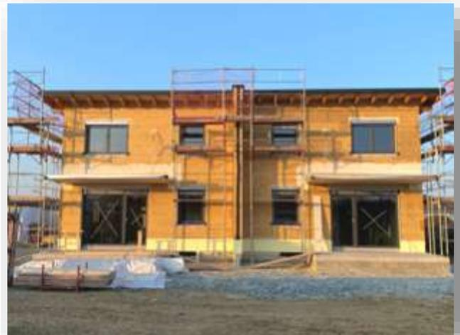
In den Tagen darauf wurden bereits die Fenster eingebaut, die Stiege zum Obergeschoß errichtet, die Zellulosedämmung außen angebracht und weitere Bautätigkeiten innen vorgenommen.
